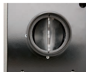
Ντάμπερ αντεπιστροφής που ανοίγει μόνο σε κατάσταση λειτουργίας
