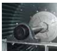
Rodamiento con tratamiento anticorrosivo corrotec + tapa de protección.
