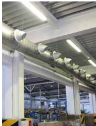
CI-300 Boca de impulsión
