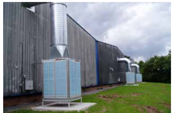
Instalación AD-40-VS con prefiltro G4 en nave industrial
