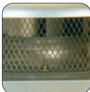
Ατσάλινο προστατευτικό πλέγμα
